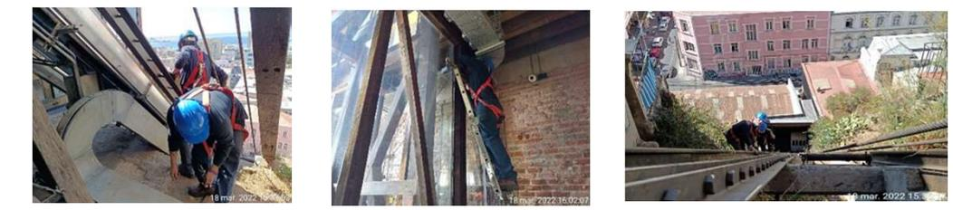
Obras a Incorporar: Sistema de enclavamiento (homologación) – polea nueva ( cambio por desgaste homologación al Cordillera)
