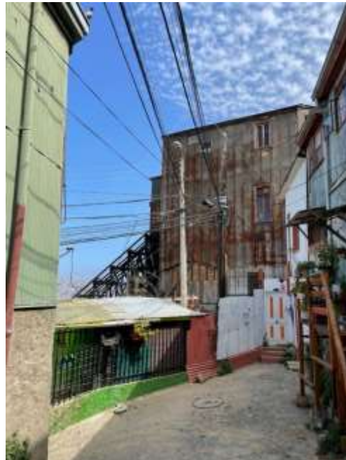
Imagen 3: Ascensor desde pasaje por donde se entraba al sector de chimenea a carbón, foto MJL 10/2021
