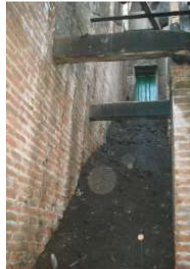
Imagen 42, acceso habilitado tras limpieza, 2012, foto informe empresa
