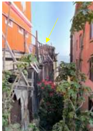
Imagen 37, puente de acceso, MJL 2021
