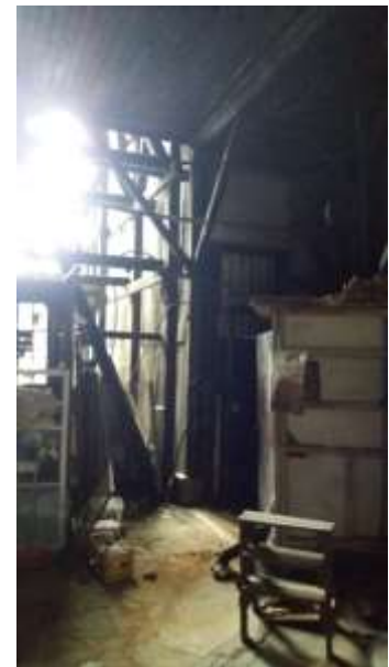
Imagen 53, Sala de Máquinas, Visita con USACH 2019
