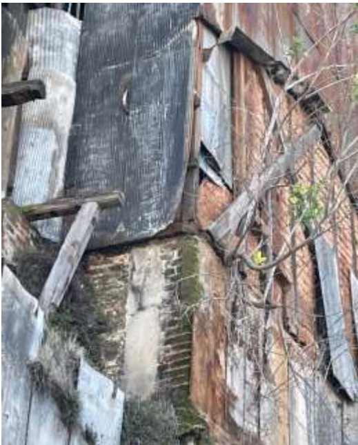
Imagen 48, demolición de costado que deja estructura a la vista, MJL 2021
