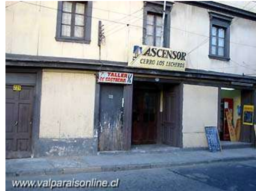
Imagen 27, www.valparaisonline.cl , imagen de archivo en internet de la estación inferior del ascensor antes del incendio.
