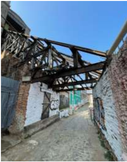
Imagen 40, acceso secundario por calle Cueto, MJL 2021
