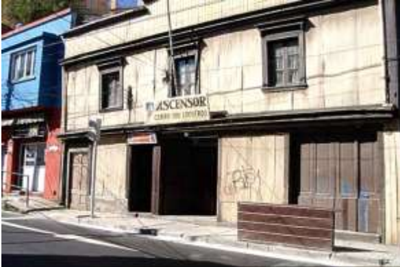
Imagen 28 Estación inferior antes del incendio, archivo DGP
