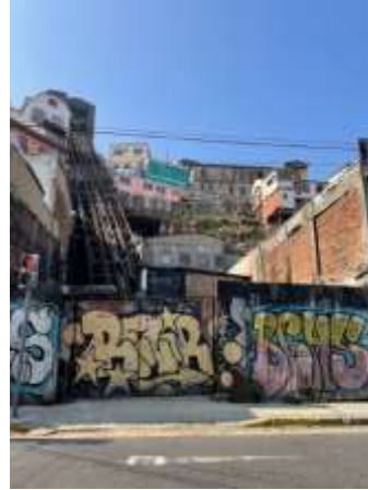
Imagen 31, estación inferior, MJL 2021
