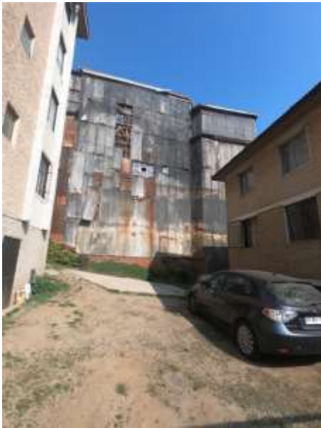
Imagen 33, vista desde calle Lecheros, MJL 2021
