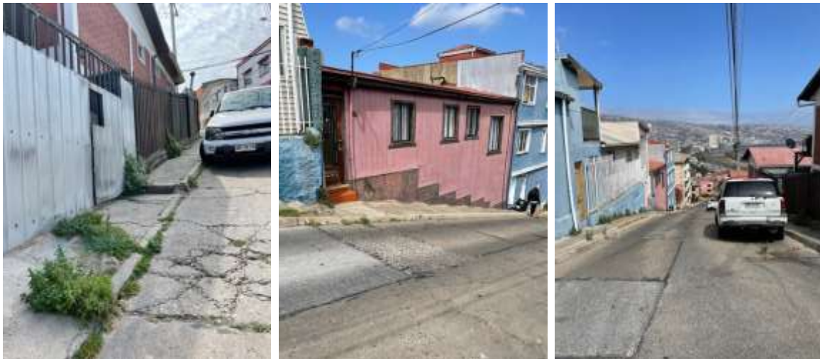
Imagen 9: fotos bajando por Los Lecheros hacia estación superior, MJL 10/2021. Se puede apreciar que es imposible usar la vereda por ancho, escalinatas y mal estado, los peatones usan la calzada, pero es riesgoso en vista que es doble vía y hay vehículos estacionados a un lado.
